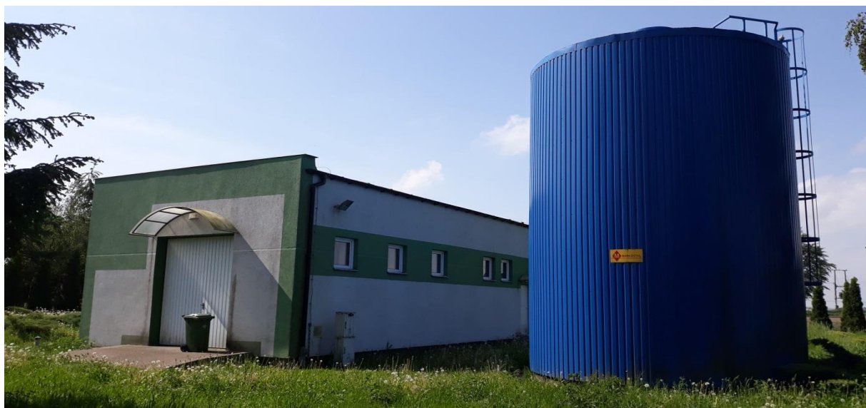
Stacja Uzdatniania Wody Chojno
