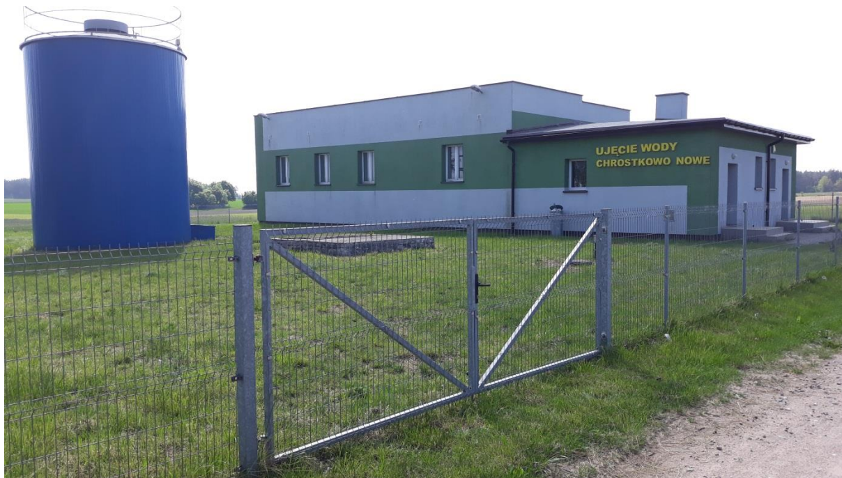
Stacja Uzdatniania Wody Chrostkowo Nowe
