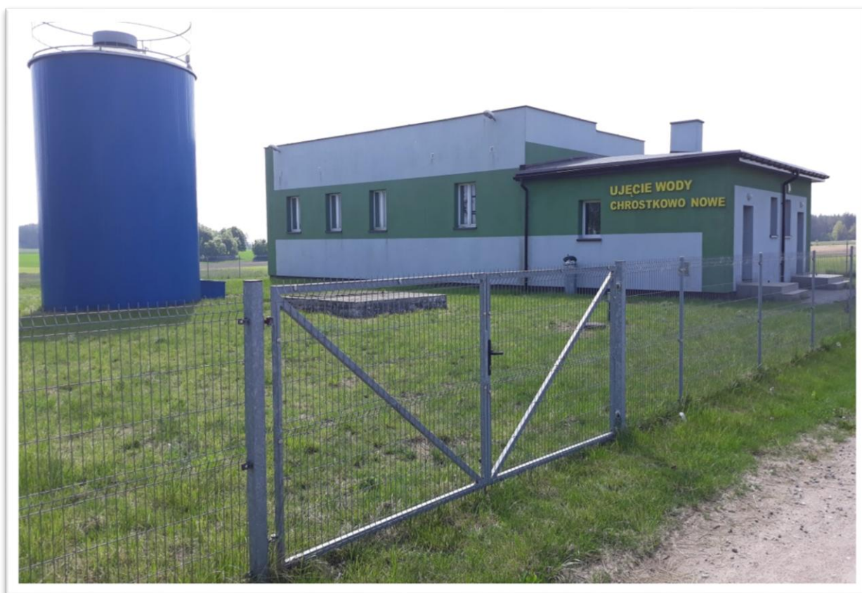
Stacja Uzdatniania Wody Chrostkowo Nowe
