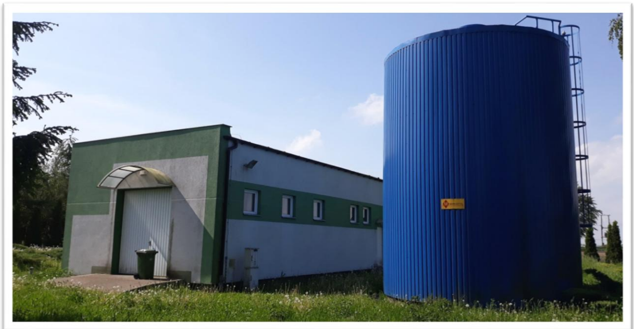
Stacja Uzdatniania Wody Chojno
