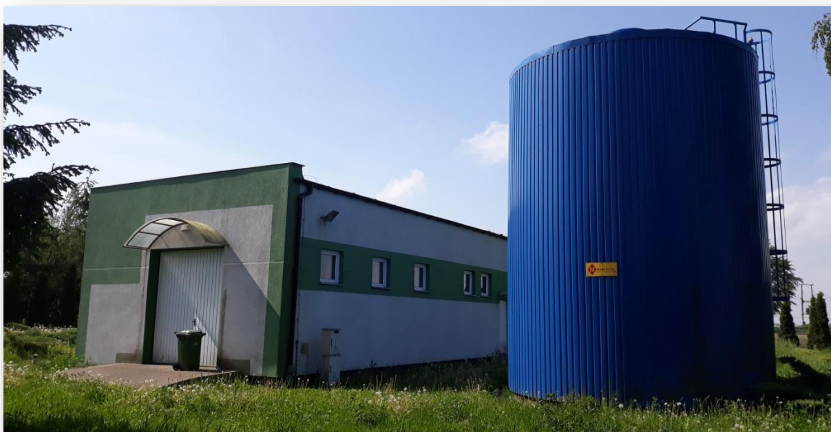
Stacja Uzdatniania Wody Chojno
