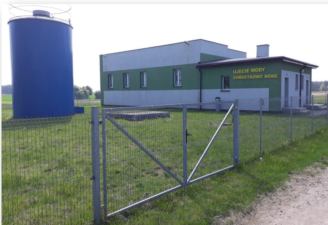
Stacja Uzdatniania Wody Chrostkowo Nowe
